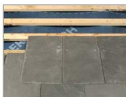
Décidez dans quel rang la chatière doit être positionnée et mettez des ardoises sur le rang inférieur. Posez les 2 ardoises directement en dessous de l'ardoise de ventilation.
