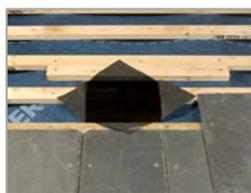
Coupez la sous-toiture en diagonale et relevez l'écran sur les liteaux adjacents et chevrons. Pour un panneau sarking rigide, découpez un rectangle dans l'isolation.
