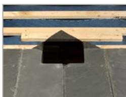
Fixez les ardoises coupées en position, en laissant l'ouverture de la sous-toiture exposée.
