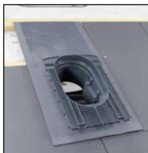
Glissez la chatière dans l'ouverture. Utilisez la ligne de centrage sur la chatière, alignez avec la ligne jointe des deux ardoises directement en dessous. Fixez par clouage à travers les trous prévus à cet effet.
