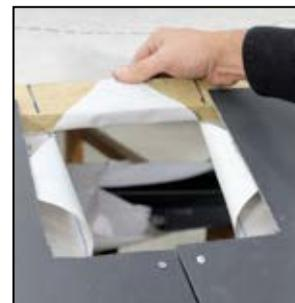
Coupez la sous-toiture en diagonale et relevez l'écran sur les liteaux adjacents et chevrons. Pour un panneau sarking rigide, découpez un rectangle dans l'isolation. Si nécessaire une sous couche d'étanchéité supplémentaire est disponible. Fixez les ardoises coupées en position, en laissant l'ouverture de la sous-toiture exposée.
