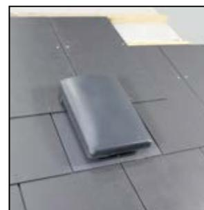
Le capuchon est clipsé solidement à la base et la pose des ardoises est poursuivie normalement.
